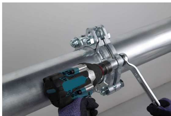
⑤ボルトを締め付ける
