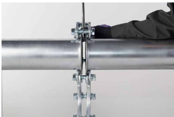
①WフランジIIをフレア部に取り付ける
