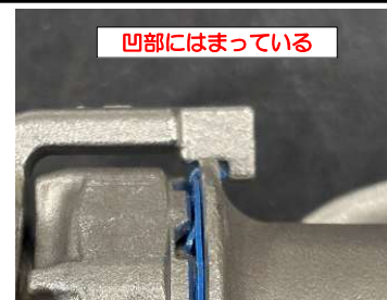
施工状態 (OK)
