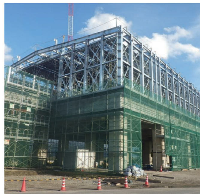
北陸新幹線 あわら除雪基地
