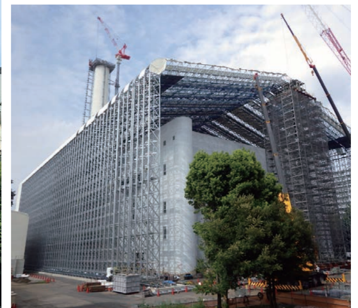
光が丘清掃工場建替工事 全覆いテント
