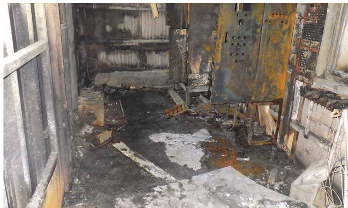
高温の亜鉛が飛散して炎上した現場事務所とトラック（提供：シーケー金属）
