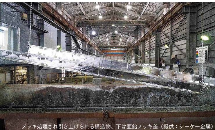
メッキ処理され引き上げられる構造物。下は亜鉛メッキ釜（提供：シーケー金属）
