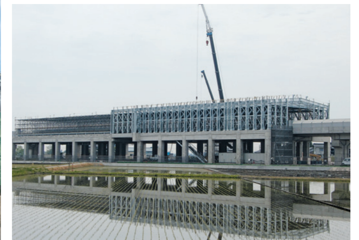
北陸新幹線 高岡除雪基地
