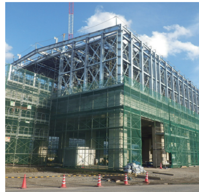
北陸新幹線 あわら除雪基地
